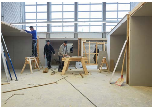
Luftig: viel Platz beim Trockenbau in Weiterstadt
